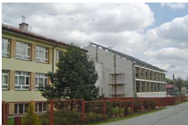
Budowa sali sportowej przy szkole w Stróżówce
