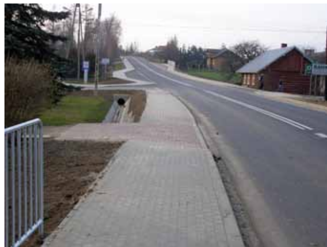
Chodnik przy drodze wojewódzkiej w Dominikowicach
