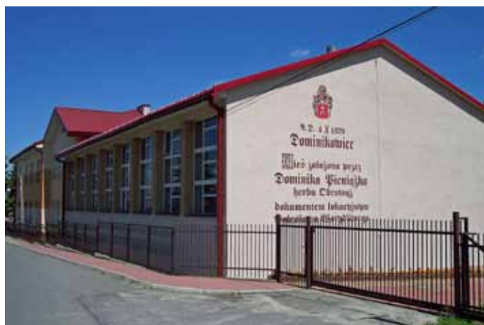
Budynek Zespołu Szkół w Dominikowicach
