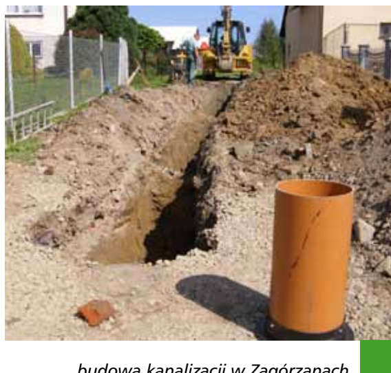
budowa kanalizacji w Zagórzanych
