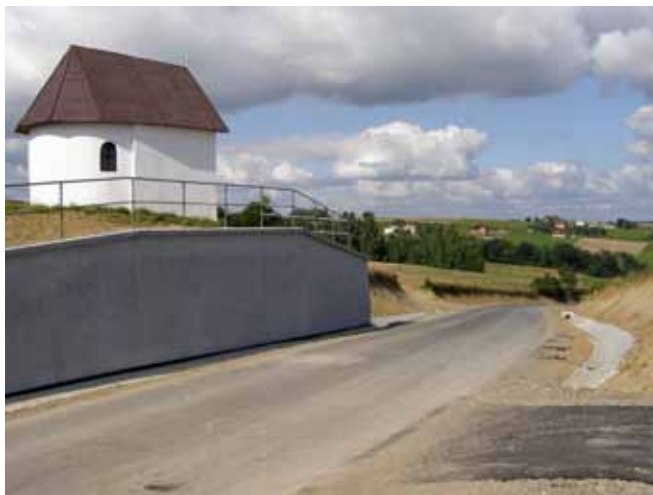
Przebudowana droga gminna w Bystrej
